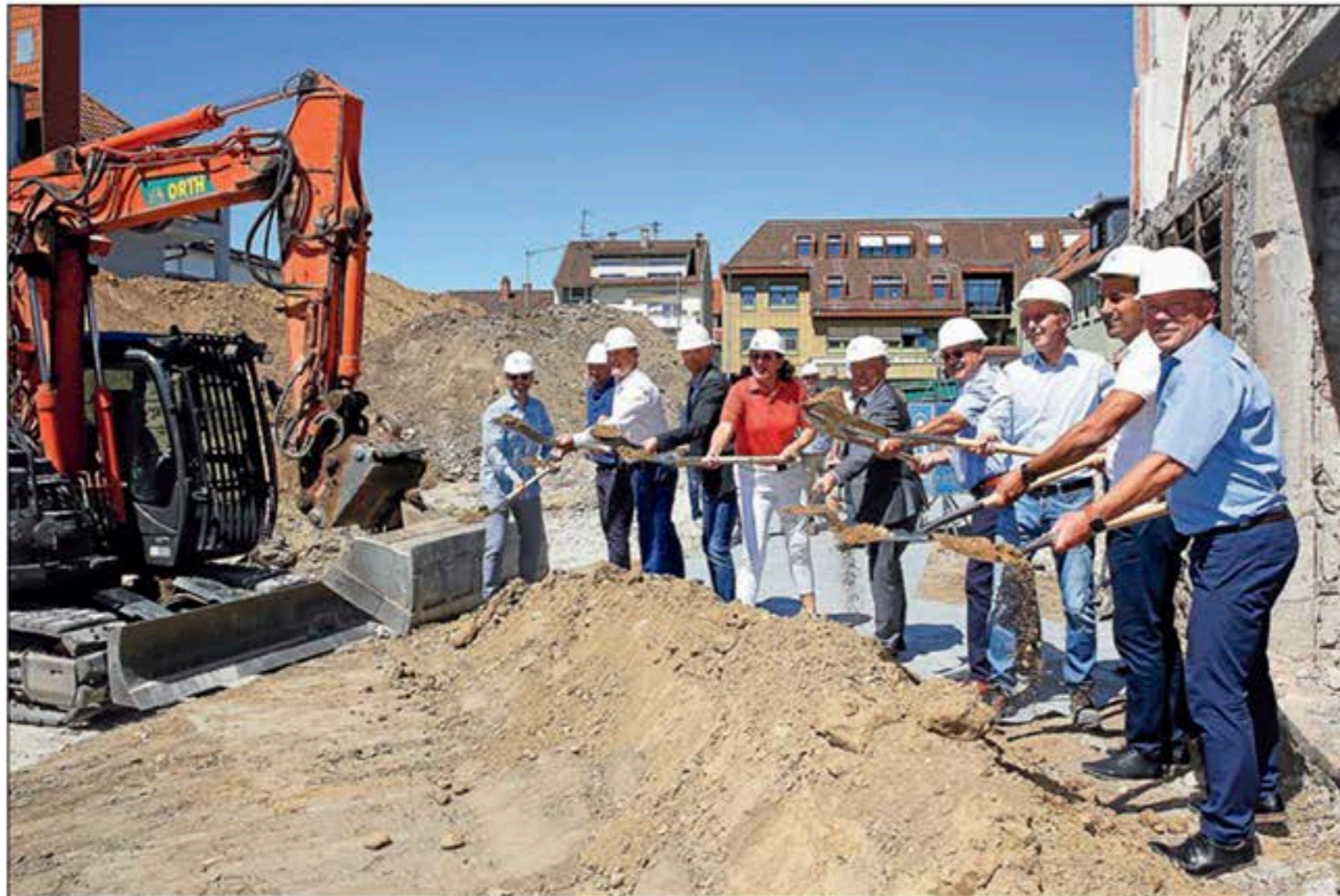
Seit 100 Jahren ist das Grundstück in Familienbesitz, jetzt starteten die Familien Wagner und Escherle mit dem Spatenstich die Bauarbeiten für 25 Eigentumswohnungen in der Wieslocher Bahnhofstraße. Foto: Pfeifer
